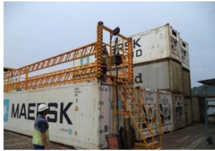
Container M&R - External
